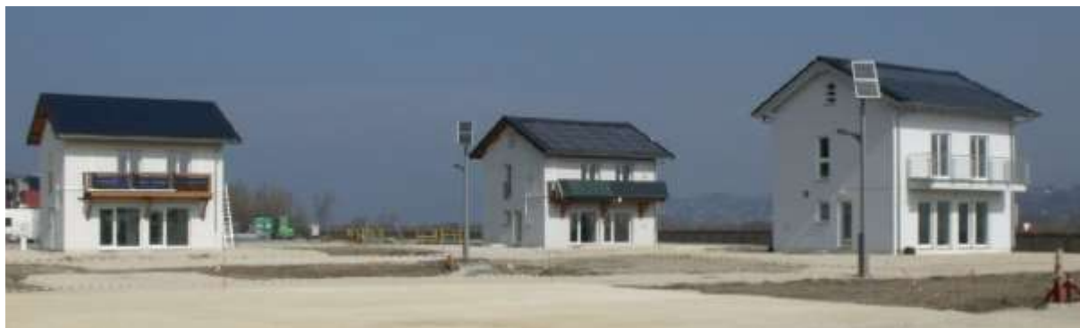
Figure 29 : les trois premières maisons INCAS construites sur le site de l'INES
